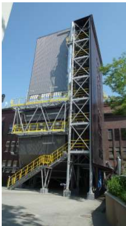
Fot.4 Instalacja odsiarczania spalin metodą półsuchą w Elektrociepłowni Pomorzany. Materiały własne.
