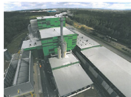
BYDGOSZCZ - POLSKA Realizacja nowej spalarni obejmującej dwie linie o łącznej wydajności 560 t/d
