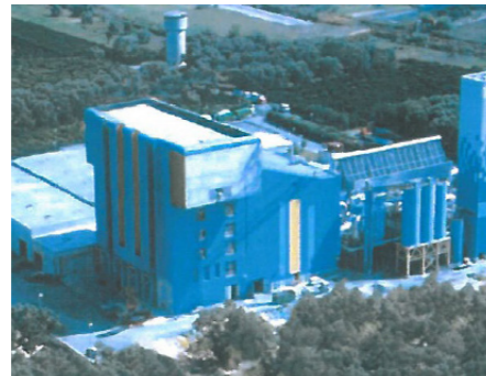
GIOIA TAURO (RC) - WŁOCHY Realizacja nowej spalarni odpadów ze złożem fluidalnym, o wydajności 500 t/d
