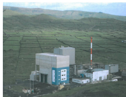
WYSPA TERCEIRA - AZORY - PORTUGALIA Realizacja nowej instalacji termicznego przetwarzania odpadów obejmującej jedną linię o wydajności 120 t/d
