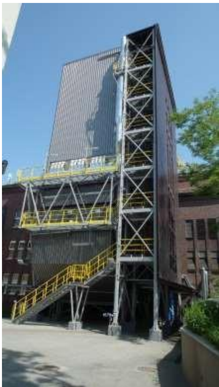
Fot.5 Instalacja odazotowania spalin w Elektrociepłowni Pomorzany. Materiały własne.
