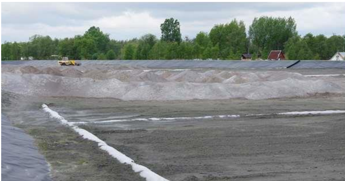
Fot.2 Składowisko odpadów Elektrociepłowni Szczecin. Materiały własne
