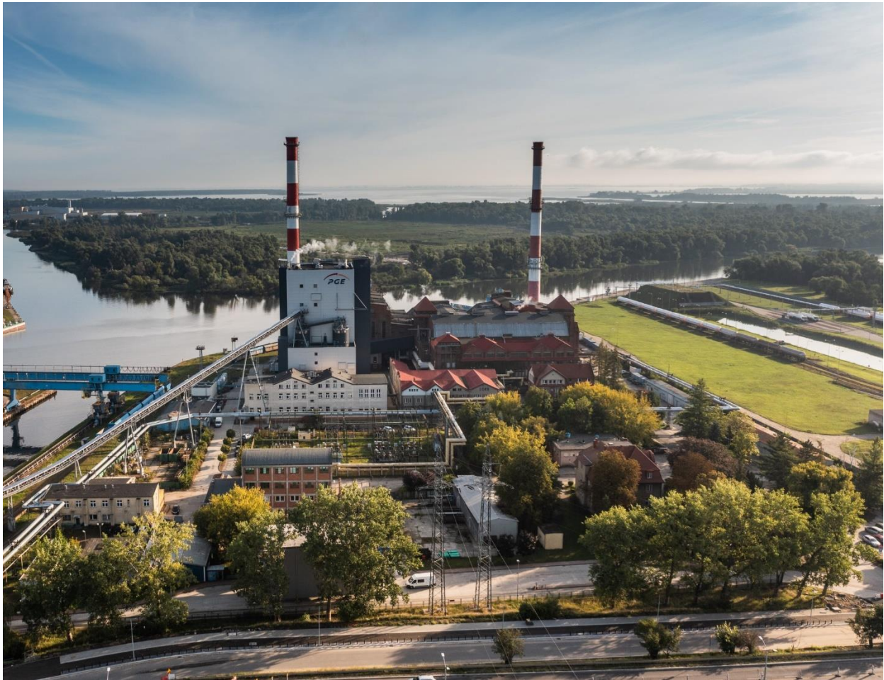
Fot.1 Elektrociepłownia Szczecin. Materiały własne.
